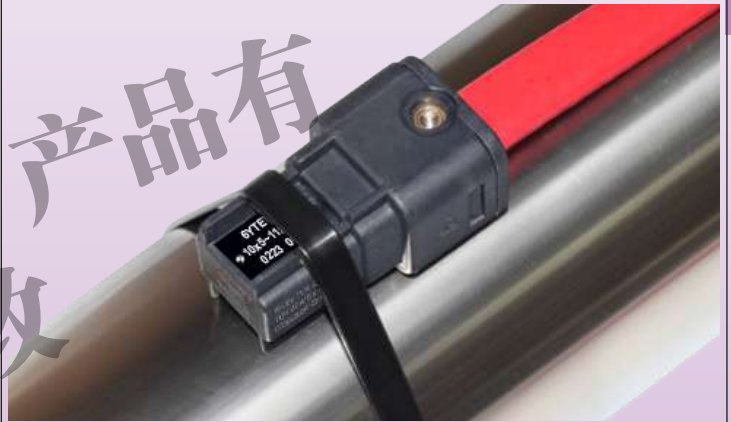
电缆插入拧紧并安装在管道上
